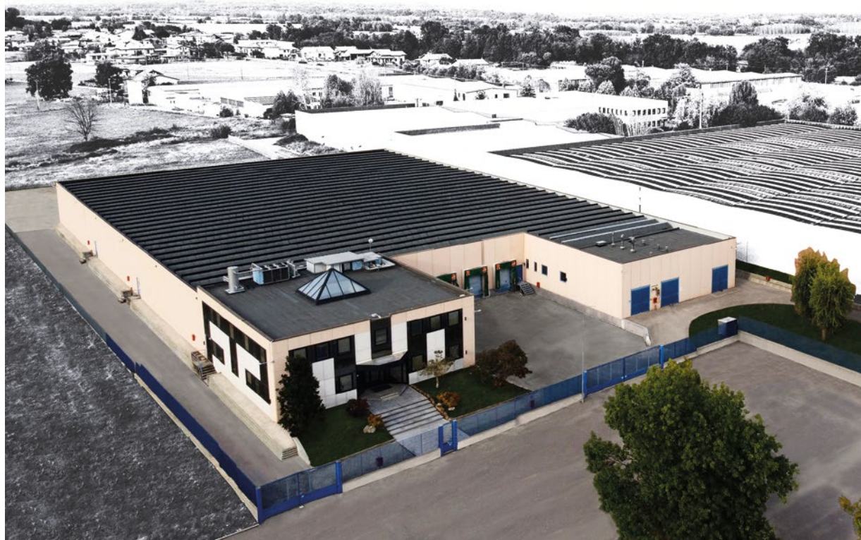
LA NUOVA PIATTAFORMA LOGISTICA E GLI UFFICI COMMERCIALI A MOTTALCIATA (BI)
